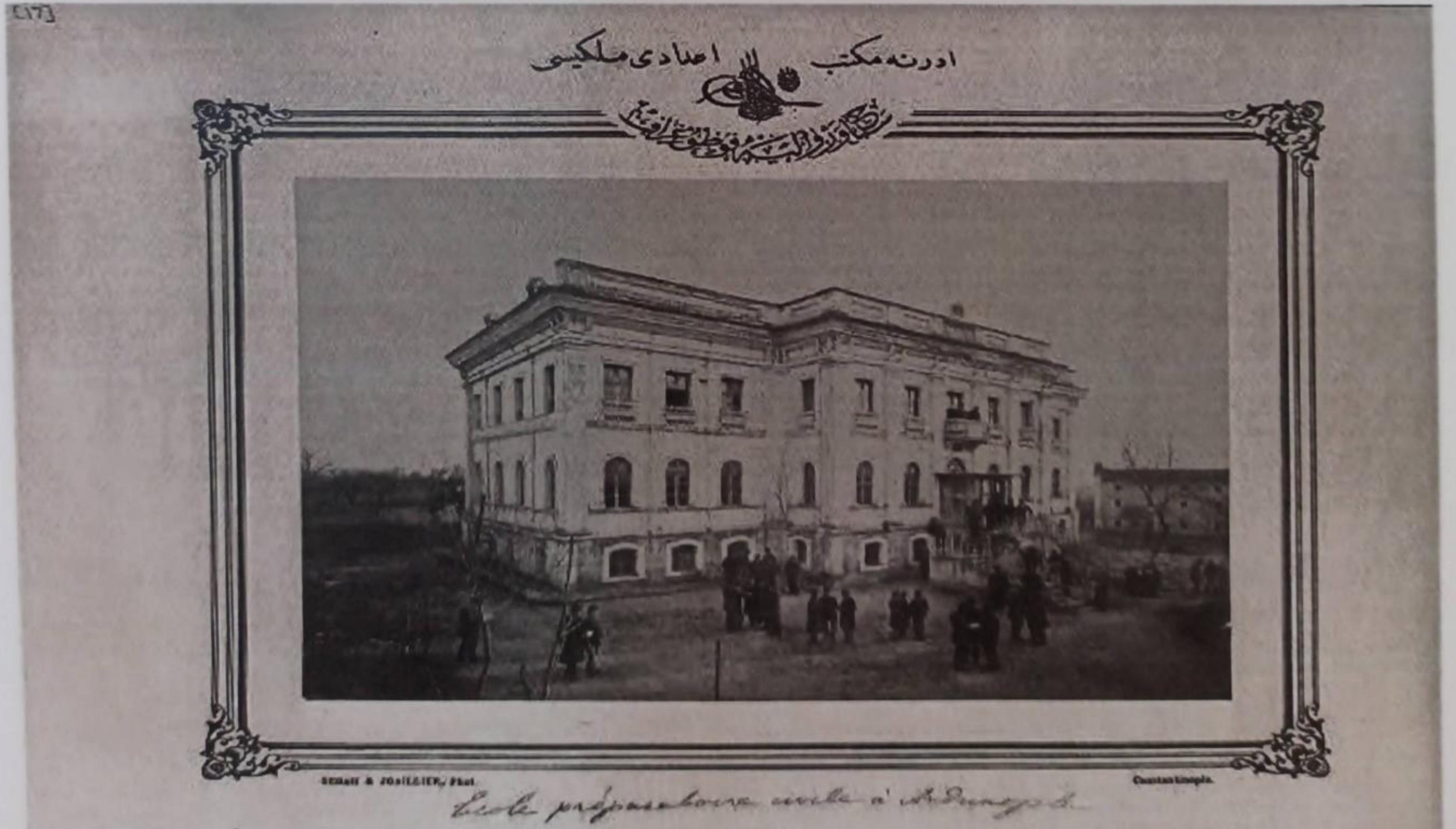
Okulumuzun 1882-1887 Yılları Arasındaki Eklenti ve Ek Kat Yapılmamış Hali
